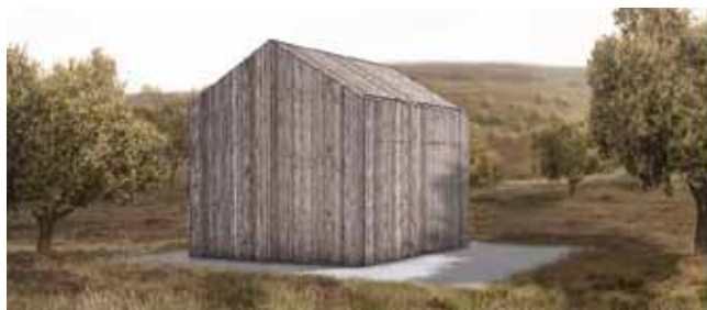
Slika 4: Kažeta je namenjena shrambi orodja in kmetijske mehanizacije ter osnovnim higienskim potrebam - enostaven kvader z dvokapno streho, kateremu se večji del južne fasade odpre, ter tako ustvari potrebno senco ob poletnih vročih dneh ali zavetje pred dežjem (avtorja: Žiga Adamčič, Ren Kaligarič; predmet: Ekološka načela gradnje).
