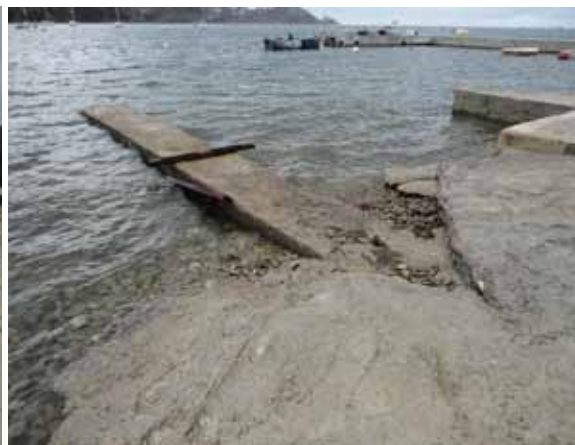
Slika 1: Zatečeno stanje; na območju obravnave obstajajo številni zametki odprtega javnega prostora vendar je njihovo fizično stanje neurejeno.
